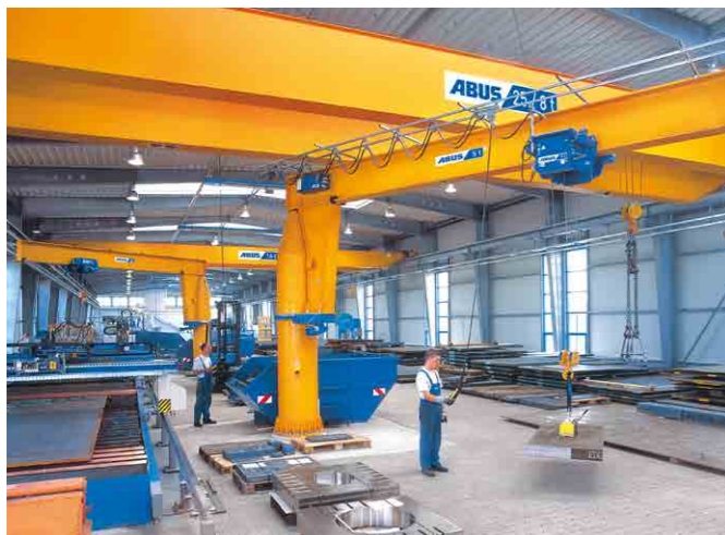
Anchor Lamina GmbH, Werkzeugbau in Chemnitz
